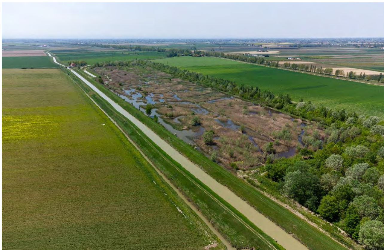
Stato attuale-Vista 03 nord-est
