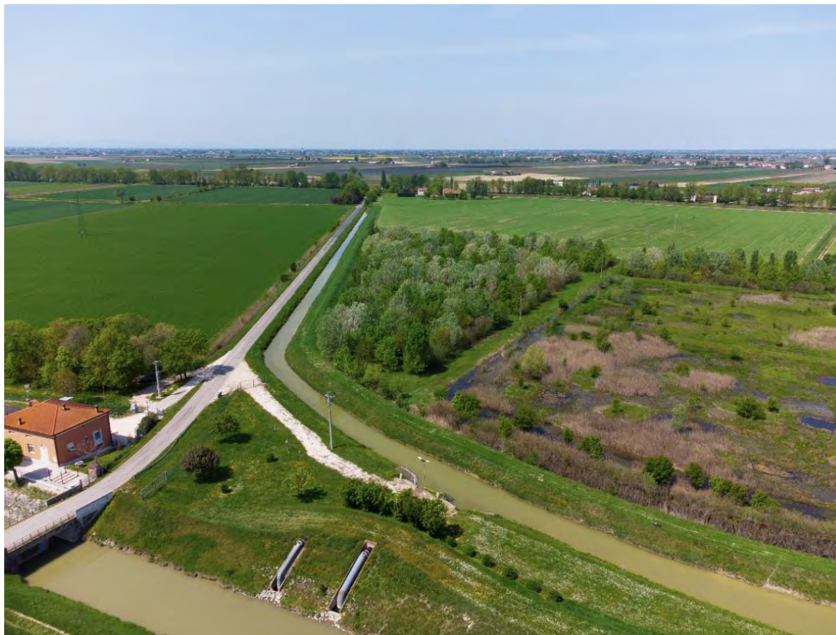
Stato attuale-Vista 02 sud-est
