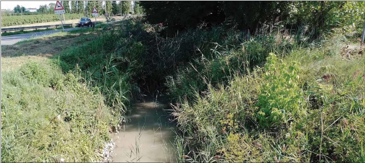
Stato attuale del Canale Naviglio Zanelli [Documentazione fotografica, immagine n° 17]
