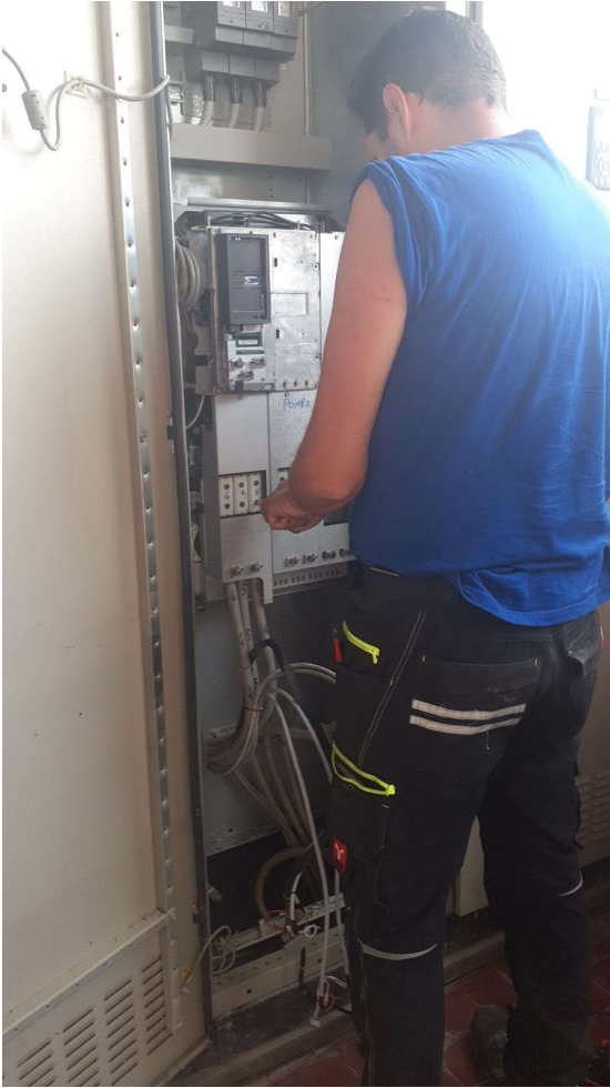
Centrali irrigue: attività di ripristino
