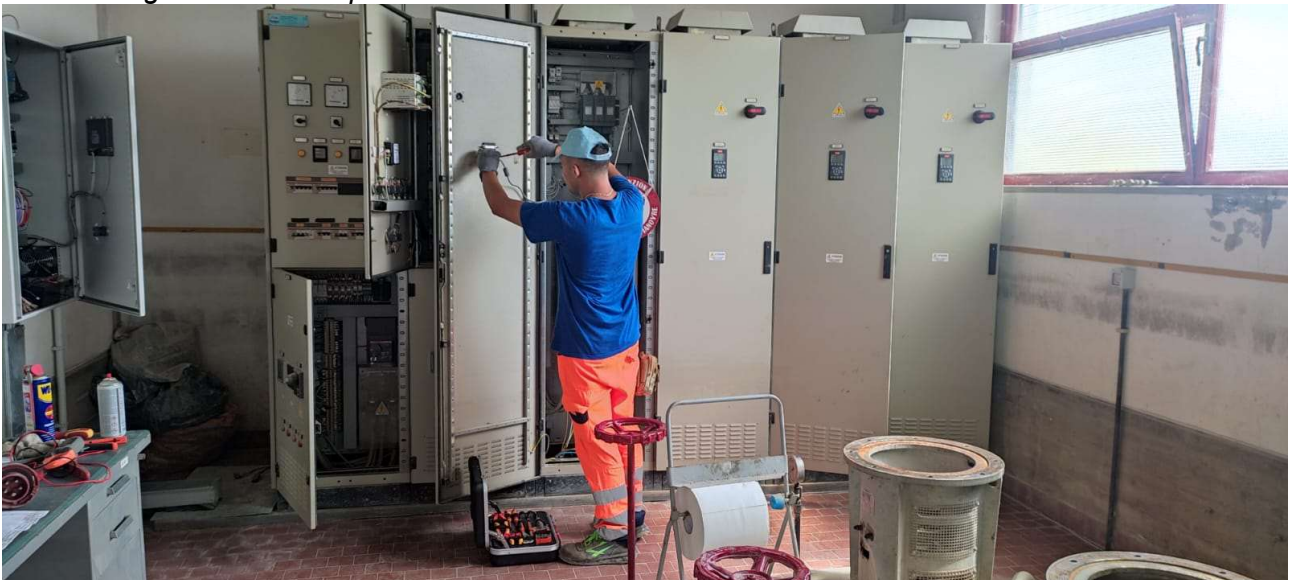
Centrali irrigue: attività di ripristino
