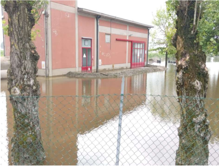
Centrale a seguito dell'allagamento del 2 maggio
